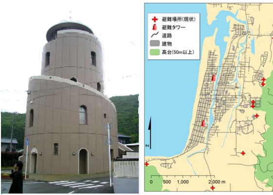
図-7 津波避難タワー(三重県大紀町)と避難施設の整備箇所
