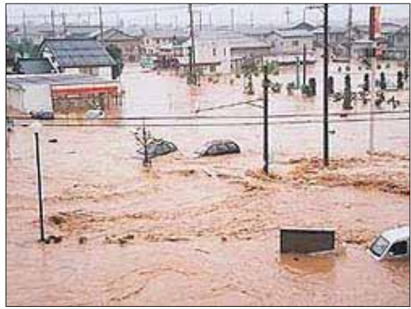
写真-1 平成16年7月新潟豪雨災害で被災した旧中之島町の刈谷田川堤防破堤地点付近
