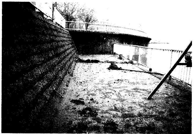
写真-4 洞爺湖畔温泉街護岸の変状と降灰
